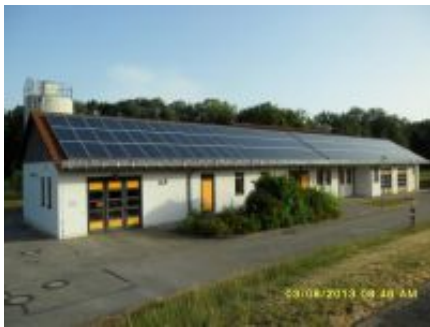
Betriebsgebäude der Kläranlage
