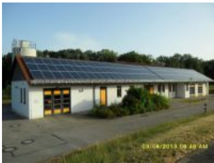
Betriebsgebäude der Kläranlage
