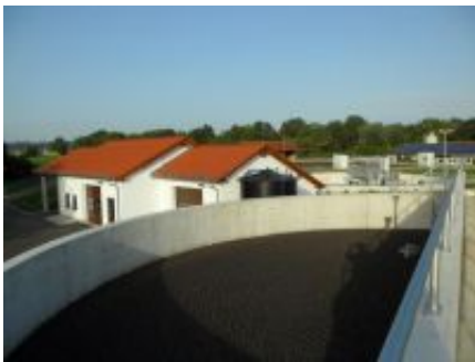
Eindicker mit Maschinenhaus
